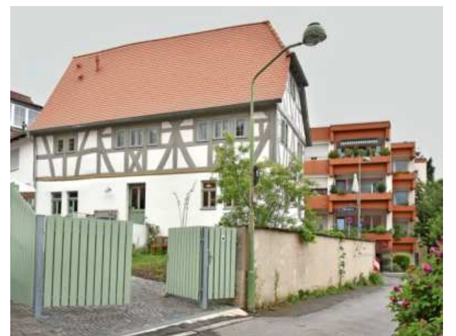
Klein, aber fein: Dieses vorbildlich sanierte Haus in Niederursel wurde in diesem Jahr mit dem hessischen Denkmalschutzpreis ausgezeichnet. Foto Christine Krienke/LfDH
