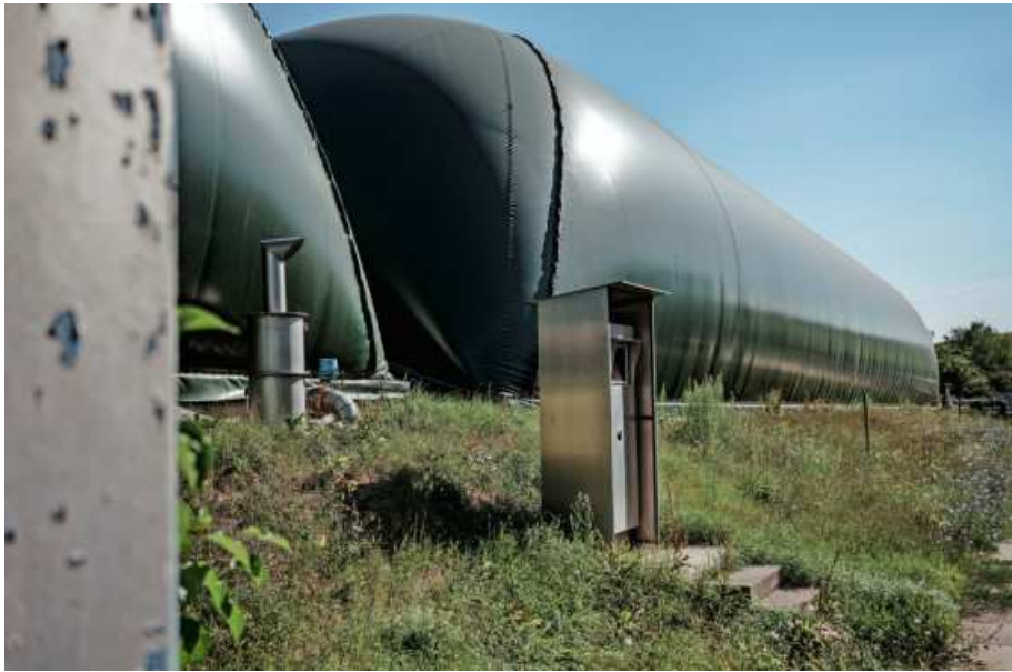
Ähneln einem Zeppelin: Der Biogastank auf dem Gelände des Deponieparks Wicker in Flörsheim
