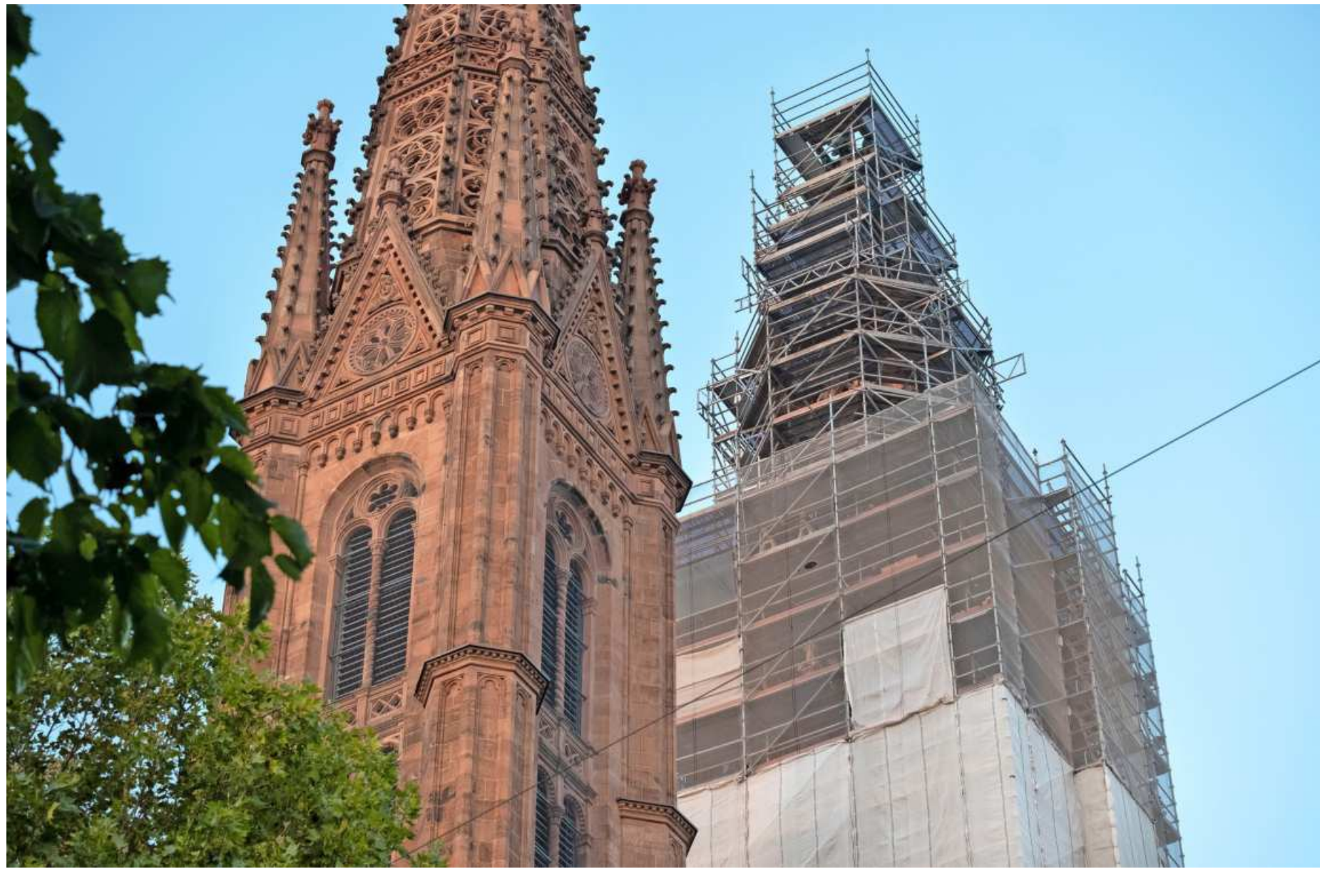
Die höchste Baustelle in Wiesbaden: Die Arbeiten an der Pfarrkirche St. Bonifatius kosten einen zweistelligen Millionenbetrag.
