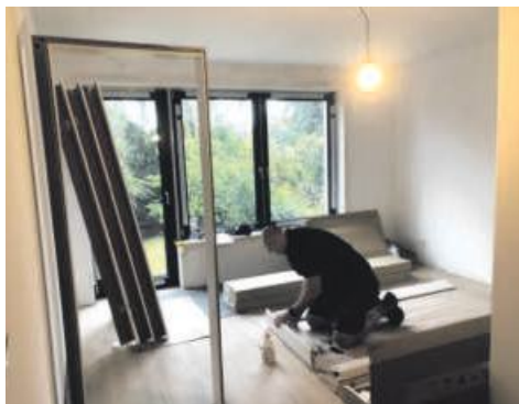
An „Tag 22“ werden im frisch sanierten Haus die letzten Türen montiert. Foto: Ronald Meyer
