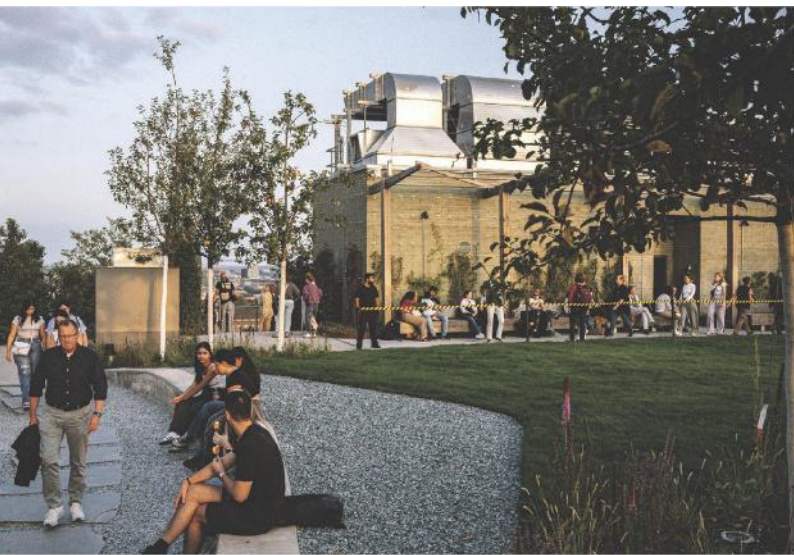
Betreten verboten: Um den Rasen auf dem Gründach zu schützen, wurde er vorübergehend gesperrt
