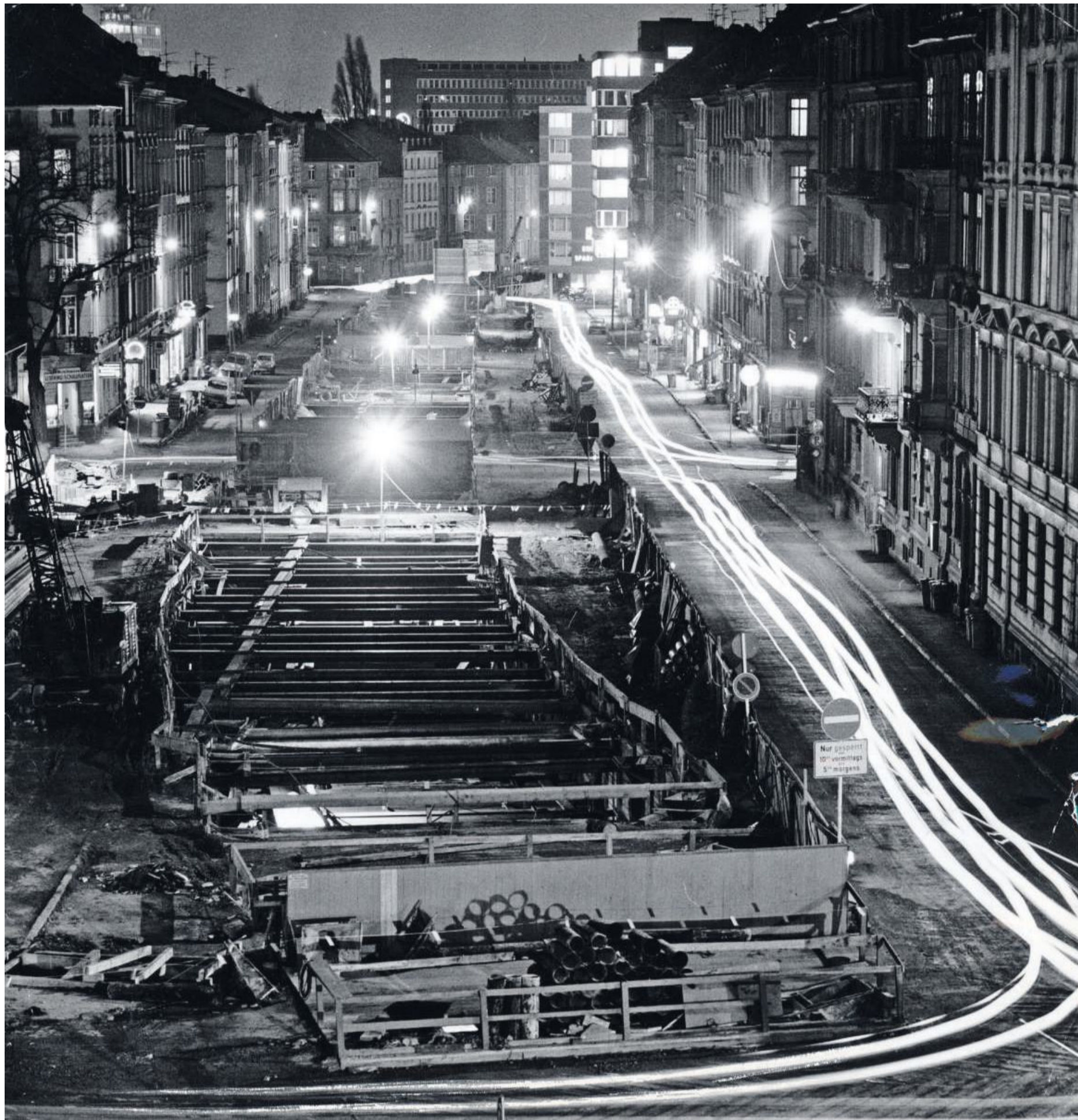
Die Baugrube nahe dem Eschenheimer Turm. Die Autos fahren über halsbrecherische Umleitungspfade.
