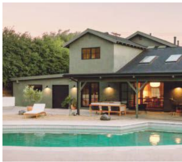
Kontrast: Außen wurde das Haus in einem schlichten Moosgrün gestrichen
