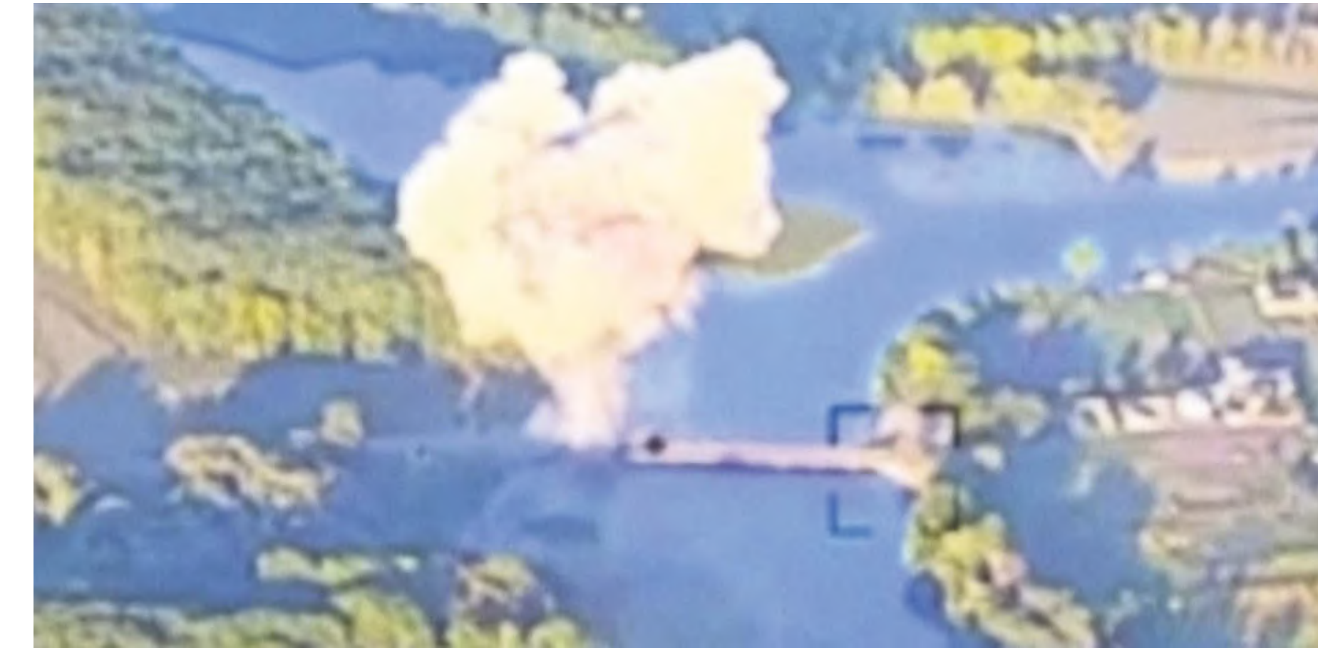
Bilder des ukrainischen Militärs sollen die Zerstörung einer wichtigen Brücke in Kursk zeigen
