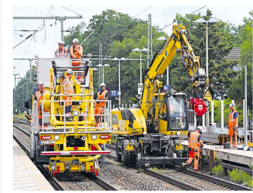
Bauarbeiten an der Riedbahn: Die Streckensanierung bei Frankfurt wird zum Härtestest für Bahn-Chef Lutz.
