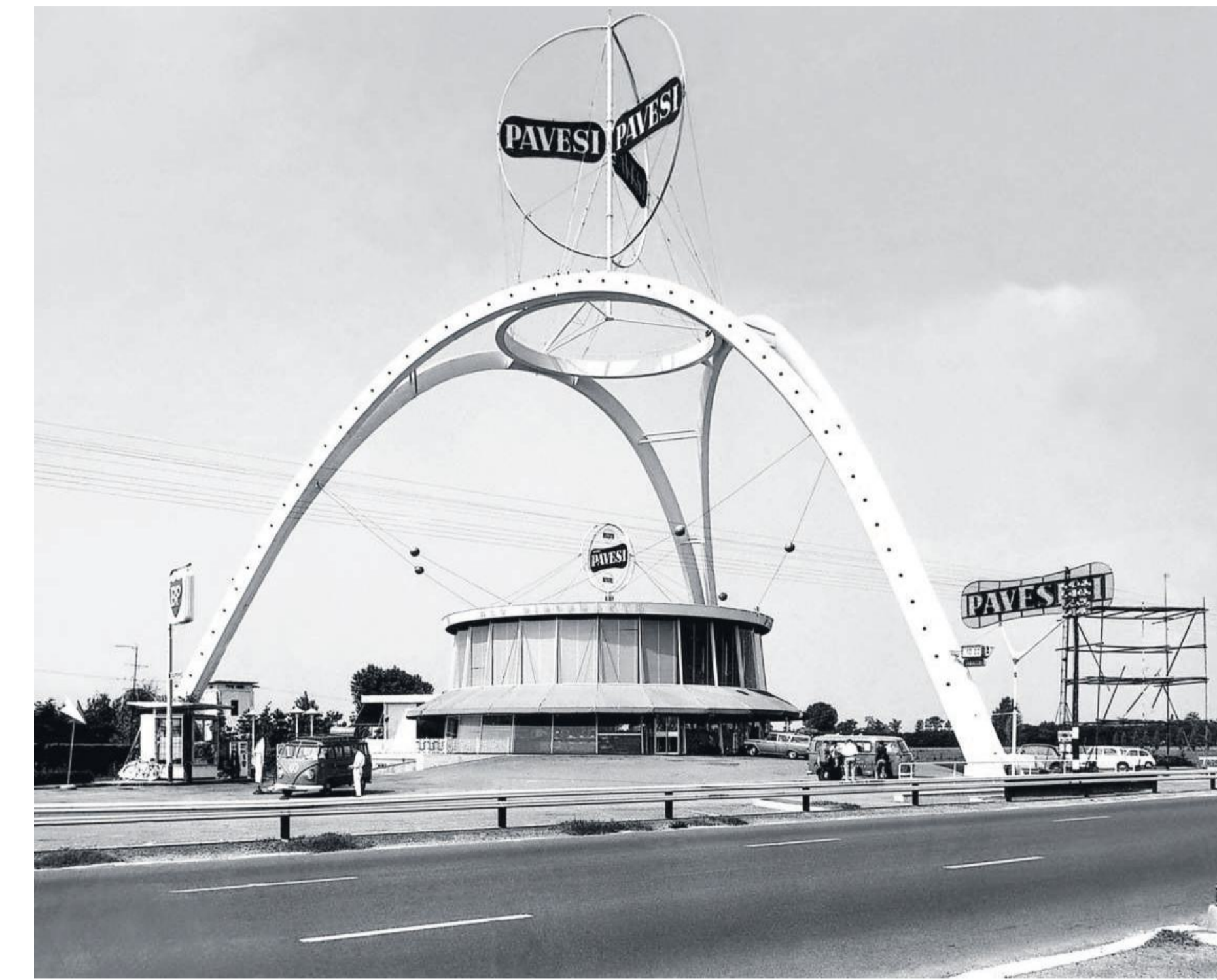
Kondensiert die Geschichte des Wirtschaftswunders: Die Autogrill-Raststätte Villoresi Ovest nahe Mailand in den Sechzigerjahren
