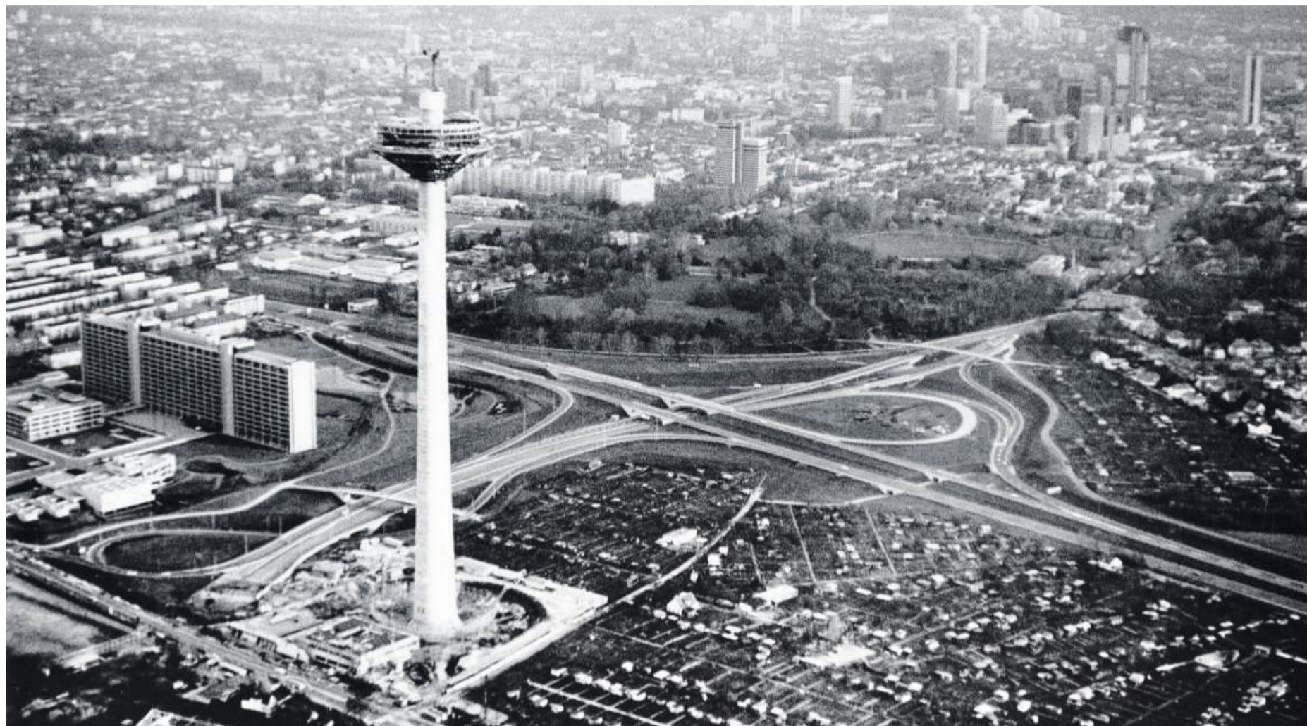
Der „Ginnheimer Spargel“: Luftbild mit Blick auf die Baustelle des Fernmeldeturms in Frankfurt Anfang 1977, links das Gebäude der Bundesbank
