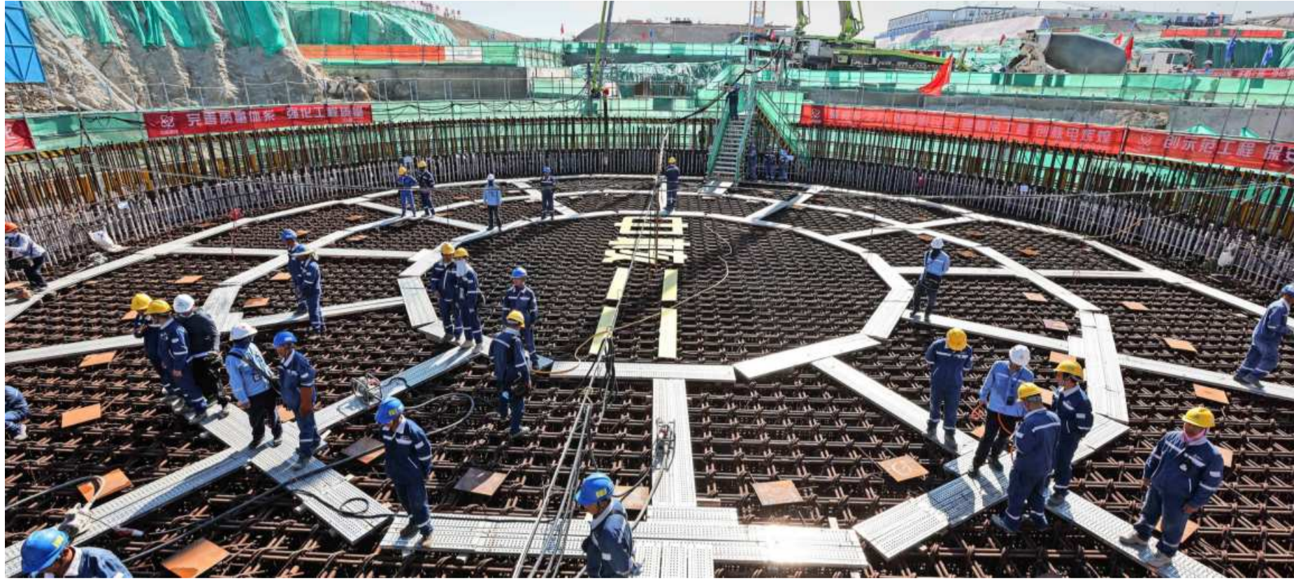
Es geht voran: Baustelle für das Kernkraftwerk Changjiang in der Provinz Hainan
