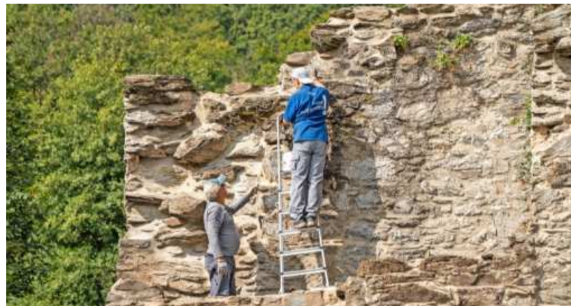
Letzte Arbeiten: Helfer an einer der sanierten Mauern
