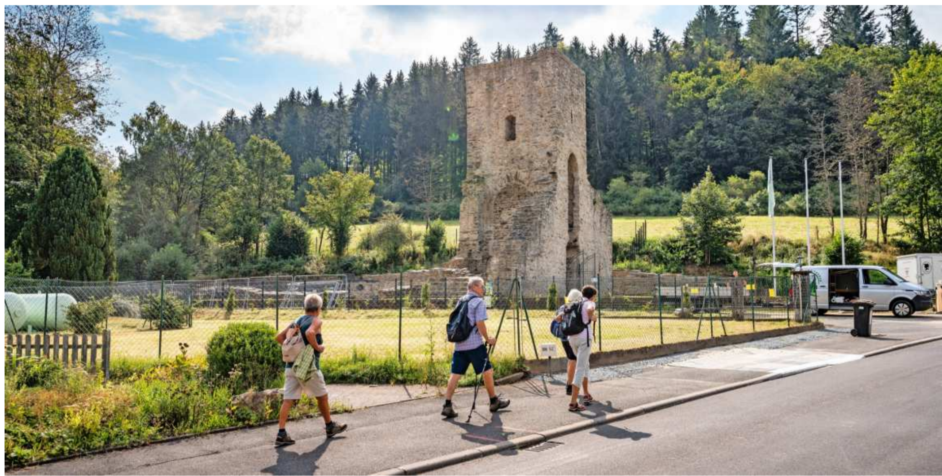
Aufwendig saniert: Wanderer vor der Kirchenruine Landstein bei Weilrod im Taunus, die am Wochenende der Öffentlichkeit übergeben wird
