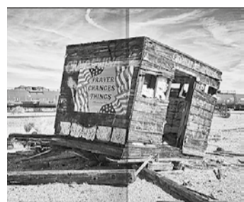
Allgegenwärtig: Elemente des Verfalls Foto: Michael Dressel
