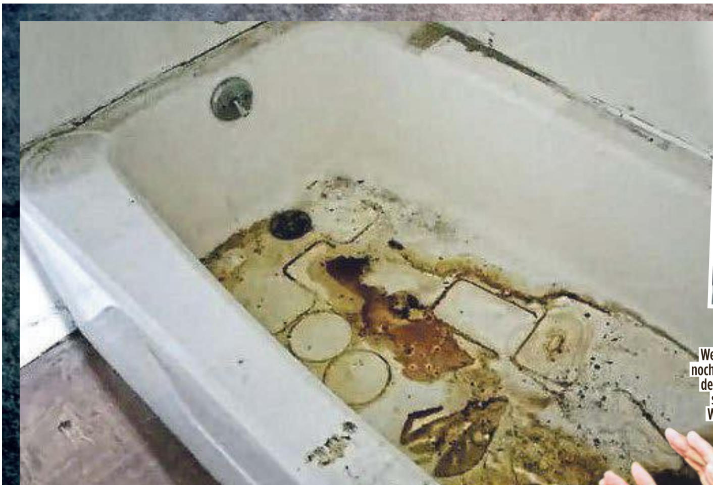
Durch diverse Wasserschäden blättern die Wandbeläge ab
