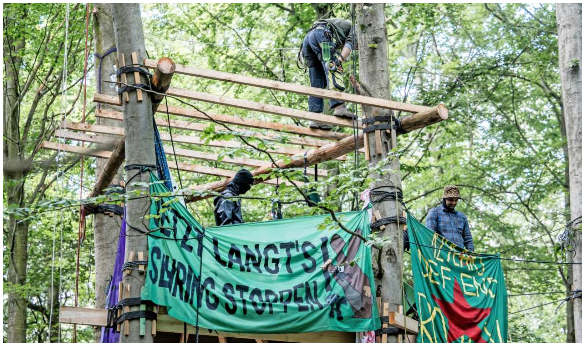
Stabil gebaut: Die von den Aktivisten im Langener Stadtwald errichtete Plattform erweckt den Eindruck, als wäre es nicht deren erste Baumbesetzung.
