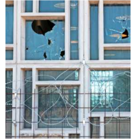
Die Düsenmaschine von Cyprus Airways wurde während der Kämpfe auf die Rollbahn gestellt, damit türkische Truppen nicht landen konnten. Die Einschusslöcher sind noch heute zu sehen, genauso wie an der Glasfront des Terminals.
