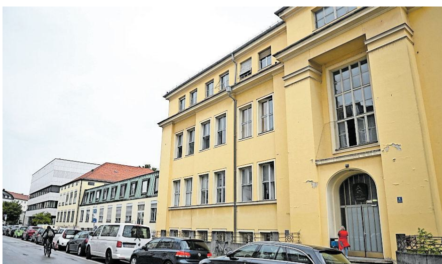
Ursprünglich war geplant, den gesamten Gebäuderiegel entlang der Königinstraße abzureißen. Nun sollen Teile davon erhalten werden. FOTO: STEPHAN RUMPF
