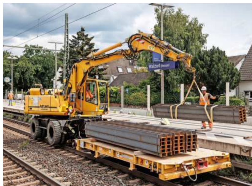
Zwei-Wege-Fahrzeug: Ein Schienenbagger im Bahnhof Walldorf Foto Lando Hass
