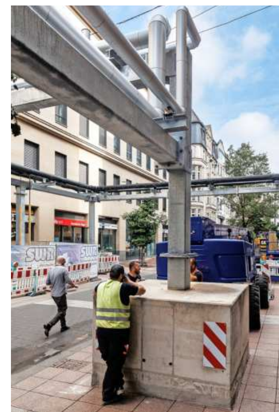
Gegengewicht: Acht Betonfundamente wurden an Ort und Stelle gegossen, um der Konstruktion Halt zu geben und Dehnungskräften entgegenzuwirken.
