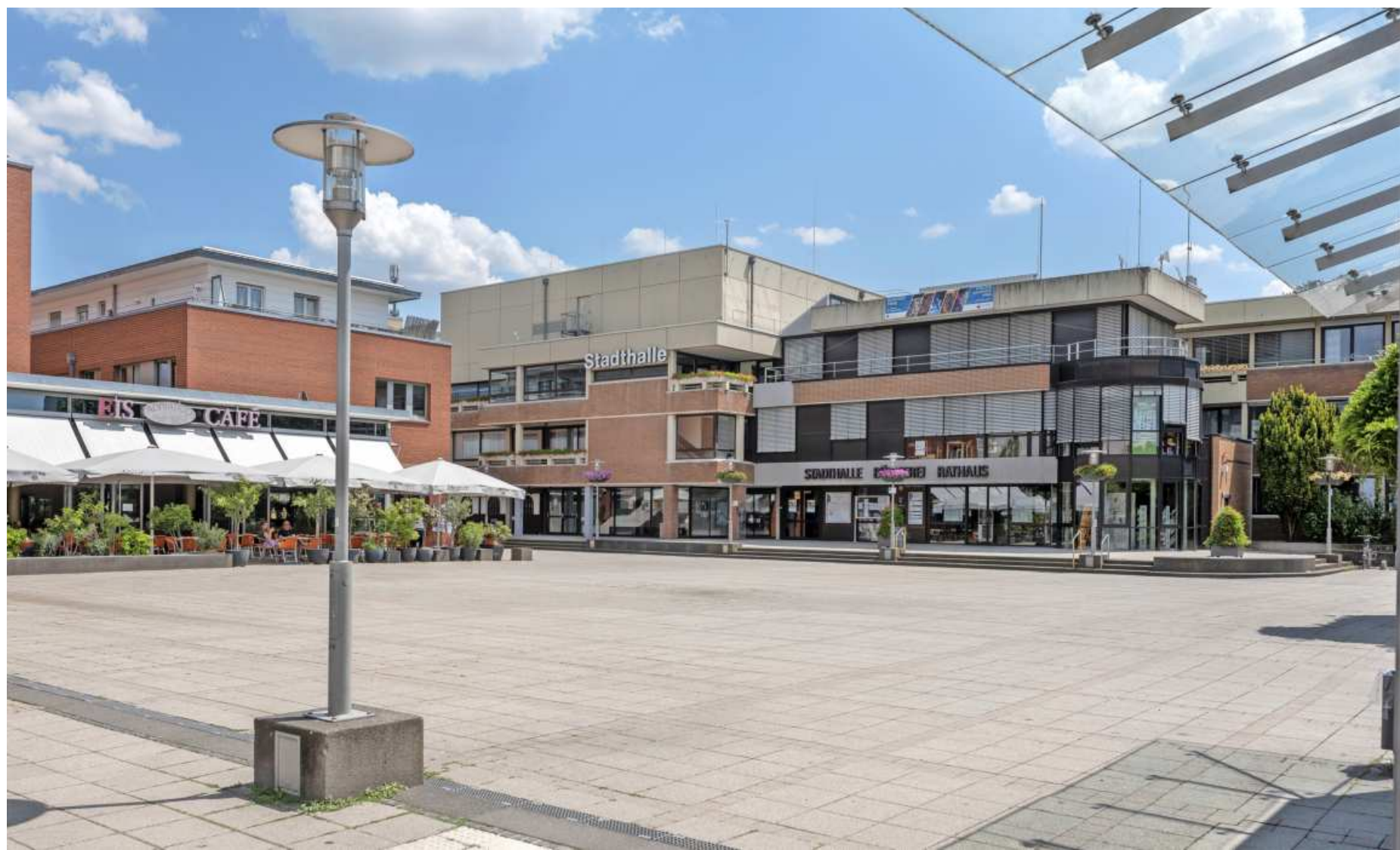
Das Rathaus bleibt: In Eschborn werden Stadthalle und Bücherei abgerissen und neu gebaut. Erst im zweiten Schritt wird der Platz umgestaltet.
