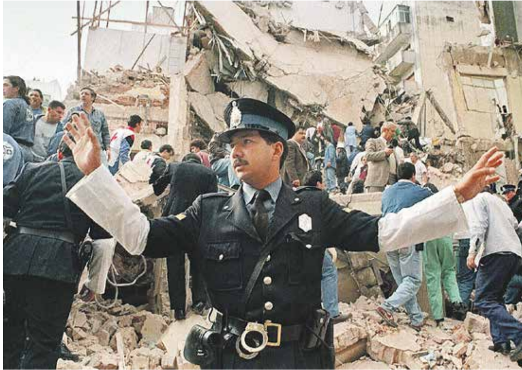
Buenos Aires, 18. Juli 1994: was vom Gebäude der Amia nach dem Anschlag übrig blieb Foto: Daniel Luna/picture alliance
