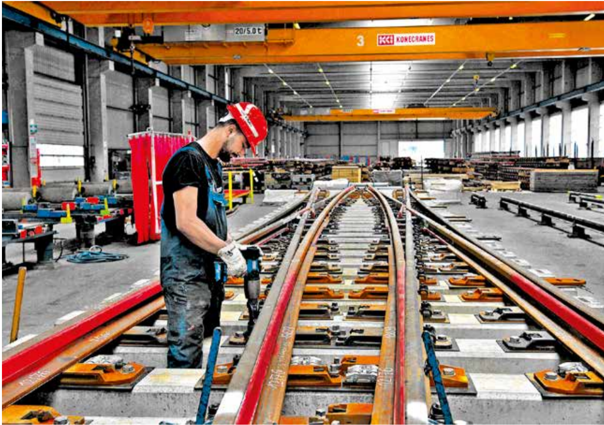
Im Werk Oberbaustoffe Witten werden zurzeit 150 neue Weichen für die Riedbahn gebaut Foto: Sepp Spiegel/Imago
