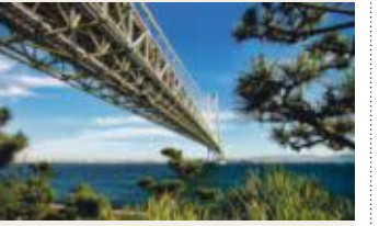
18.10 Hängebrücken sind Monumente der technologischen und mechanischen Höchstleistung ihrer Zeit. Die Doku zeigt spektakuläre Konstruktionen und gibt Einblick in die tägliche Wartung. Zu ihnen gehört die japanische Akashi-Kaikyo Brücke, die dreimal länger ist als die Golden Gate Bridge.
