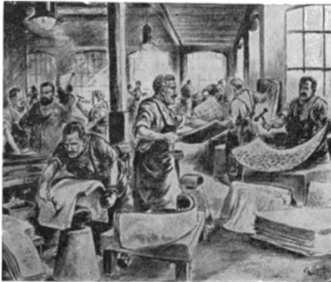
Handgehämmerte Bleche für die Kotflügel benötigen acht Stunden Arbeitszeit
